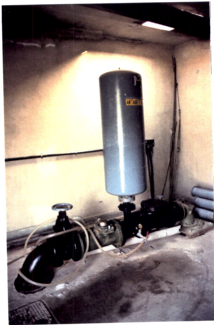
FOTO 1: Captación de aguas subterráneas.
