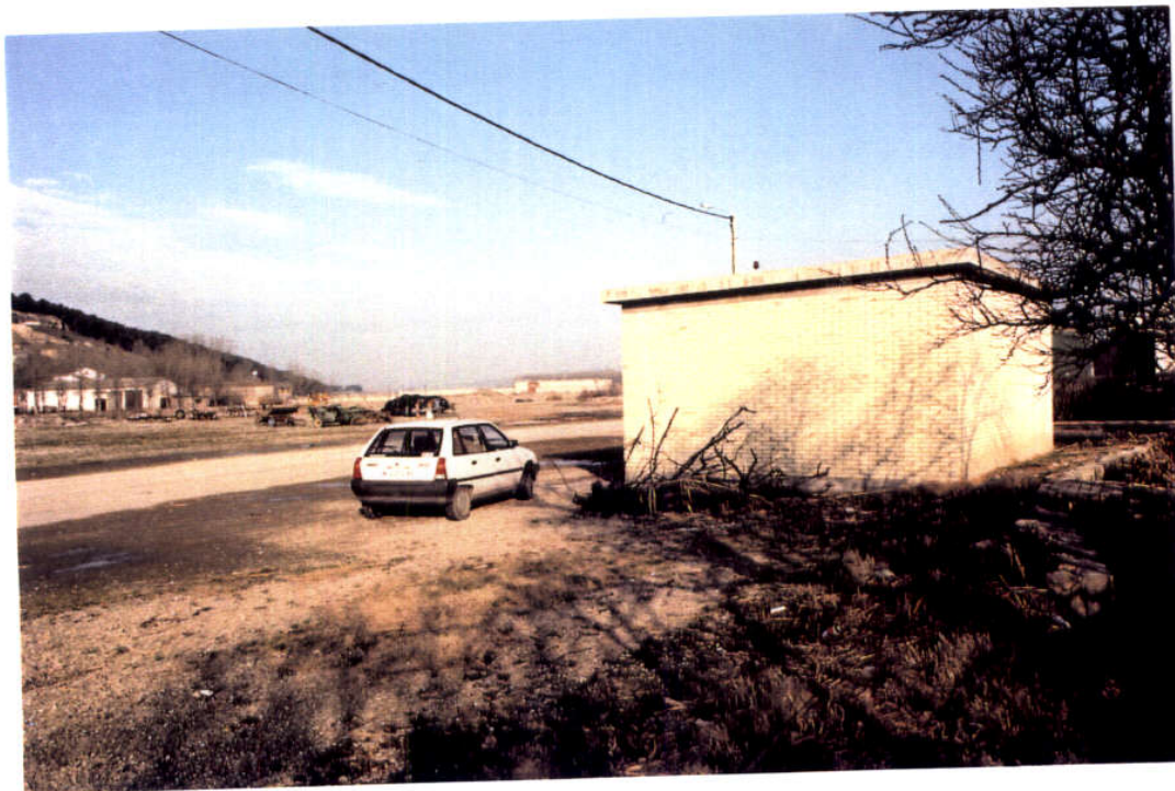
FOTO 2: Vista general de la captación.
